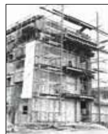
建設中の校舎
